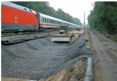
Einbau Geogitter bei MIP-Verfahren
