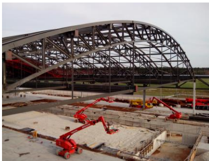
Bau der Dachkonstruktion
