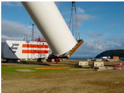
Aufstellen des Turms
