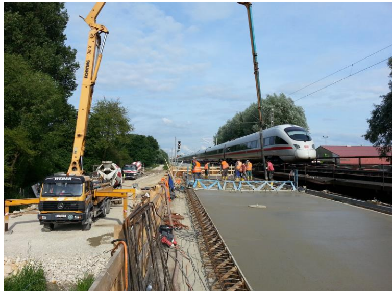
Betonieren Überbau Gl. M-IN der EÜ Paar für BPH 18.3
