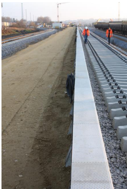
Neubau Bf Baar-Ebenhausen
