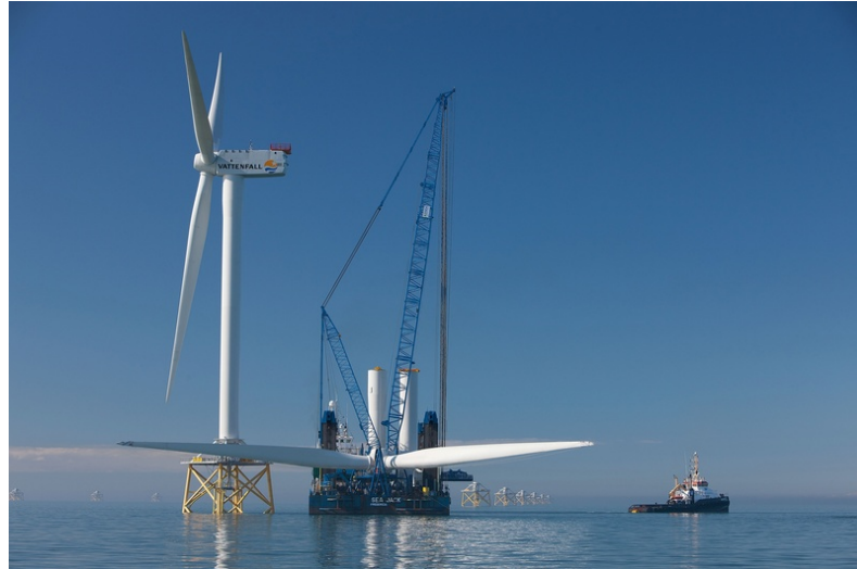
Offshore Windpark im Bau
